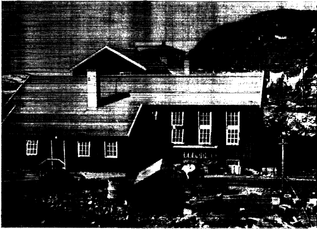
Elektricitetsværk af standardstørrelse.
