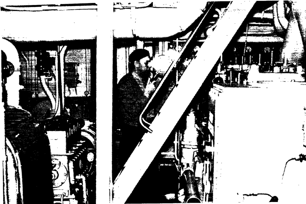
Maskinmesteren har nok at tage vare på i „Misigssut“s store og stærke maskineri.
