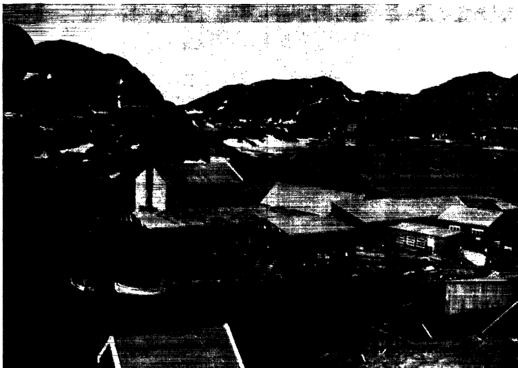
Fiskeindustrianlægget i Sukkertoppen er installeret i tidligere pakthuse og tilbygninger til disse, mens selve maskineriet er nyt og moderne. Til venstre ses fiskeribroen med kraner, dernæst renseperron og bag denne fiskemølsfabrikken. I bygningen til højre er fryseri med lager.
