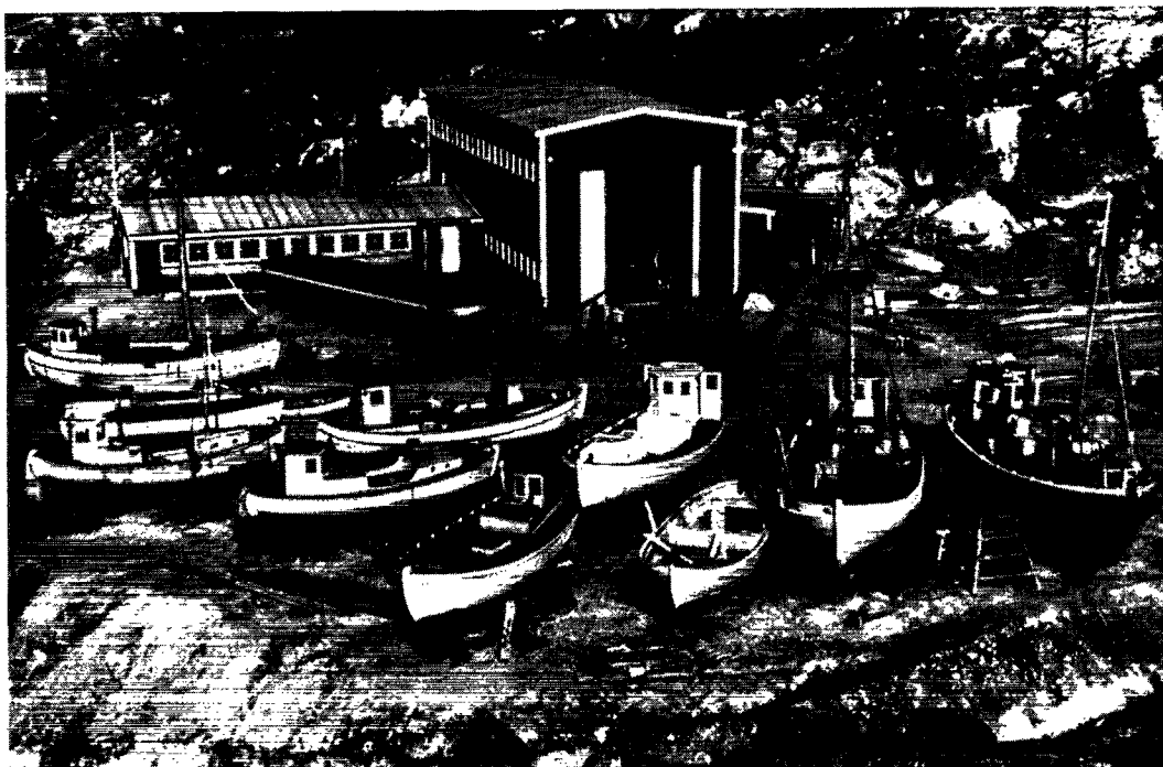
Bådeværftet i Julianehåb er udstyret med bedding for land- og søsætning af både op til 40 tons. Værftet har bådehal og maskinværksted.
