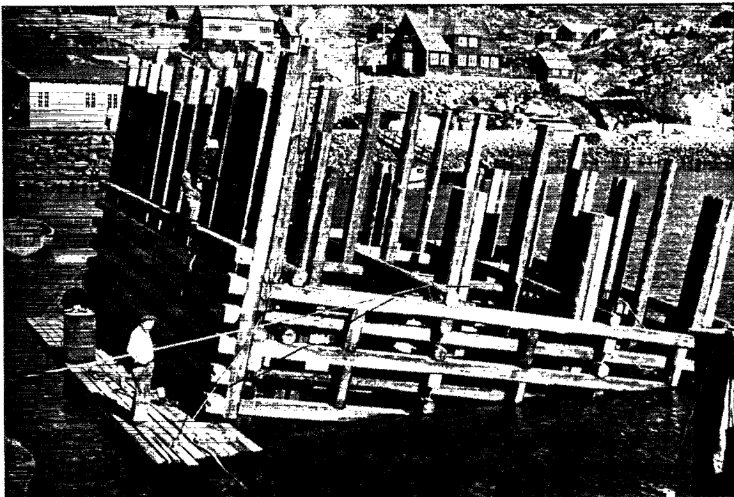
En af de svære tømmerkister til atlantkajen i Julianehåb. Tømmerkisten opbygges svømmende og sænkes på plads med stenfyld.
