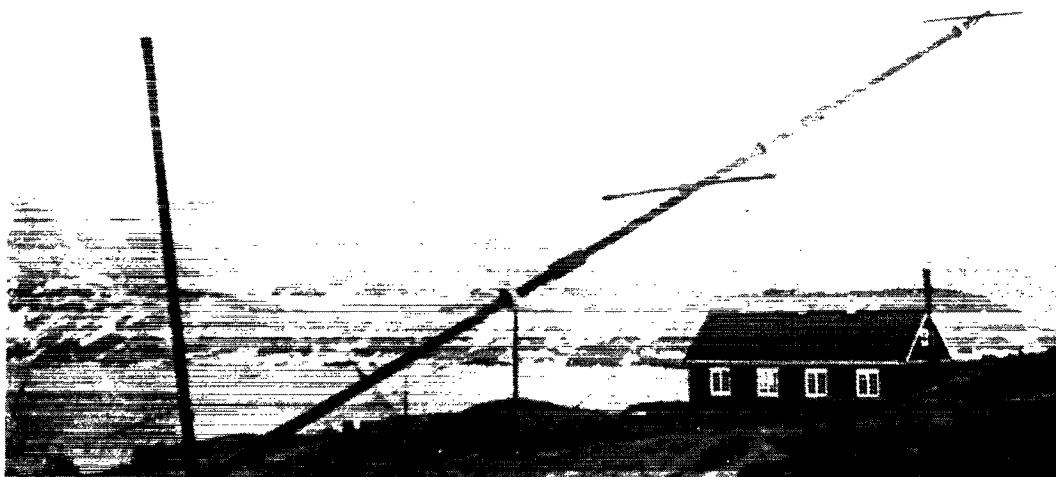
Den første radiomast i Angmagssalik ved at blive rejst.
