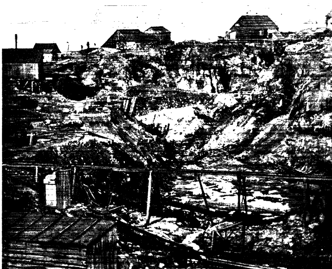
I forgrunden ses broen, der fører til brud A, til venstre pumpe-maskinen og tjenerindernes hus („Hytten“). Bag ved bruddet ses det gamle bageri, pakhuset maskinmesterens hus, tilhøjre „Amerikanerhuset“ og kontrollørens bolig. Fotograferet 26. september 1868.
