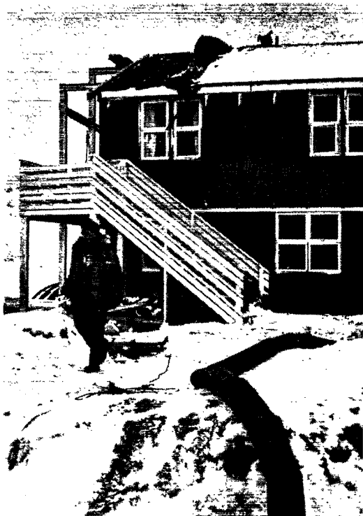
Skader på byens hospital.
