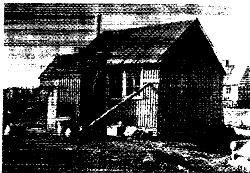
Gammelt typehus, Narssaq. Huset holdes på plads af forankrede stålwirer og støttes mod sydosten af trælægter.
