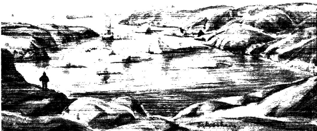
Havneindløbet ved Jakobshavn, tegning, 1925. (Tilhører Ministeriet for Grønland).
