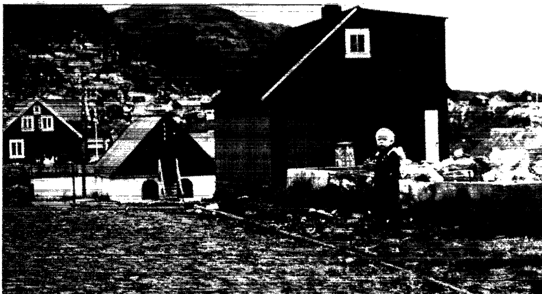
Stenhuset med trappen i gavlen er et tidligere kolonihus i Julianehåb. Det er indrettet som lokalmuseum og skal bevares for eftertiden. De omliggende selvbyggerhuse fjernes.
