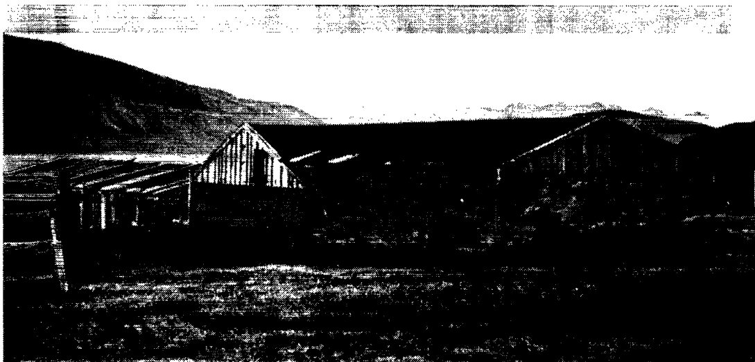
Primuiv betonstøbt ladebygning i Igaliko.
