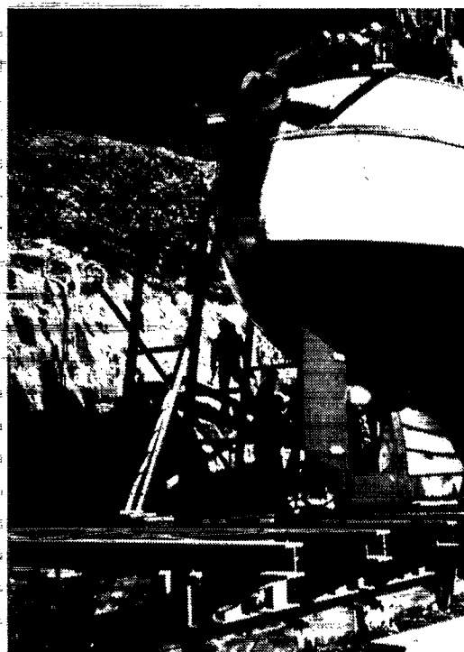
Der er overalt i Grønland etableret anlæg af mange forskellige arter, og disse danner tilsammen et veludviklet teknisk grundlag, som fremtidige tekniske aktiviteter vil kunne udnytte. Bådeværftet i Frederikshåb.
