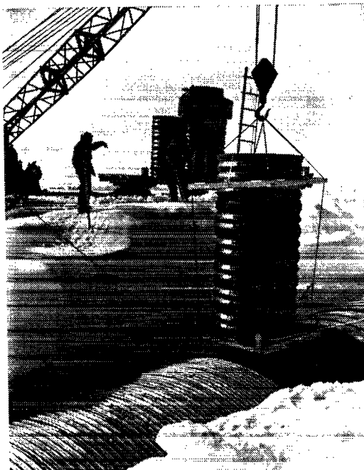
Ventilationsskakt bringes på plads i Camp Centurys rørsystem.
