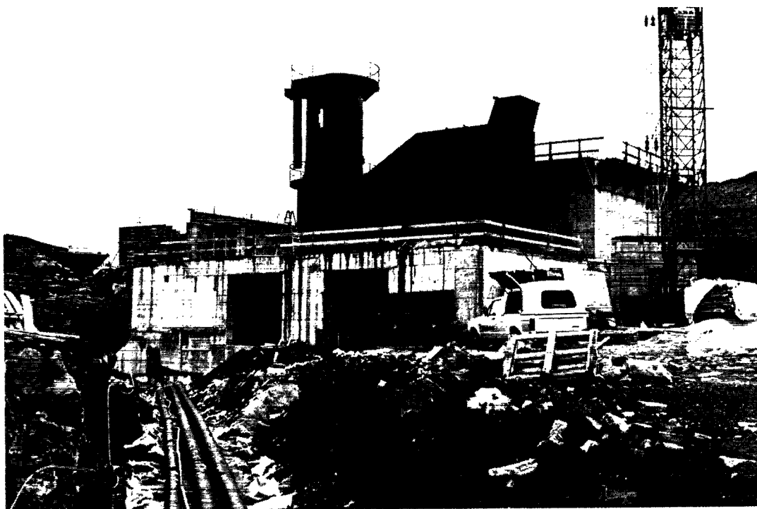
Forbrændingsanlægget i Nuuk under opførelse, september 1987. Foto: Lisbet Lyager.
