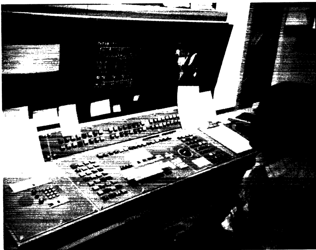
Operationsrummet hvorfra de enkelte brønde og procesenheder overvåges og styres.
