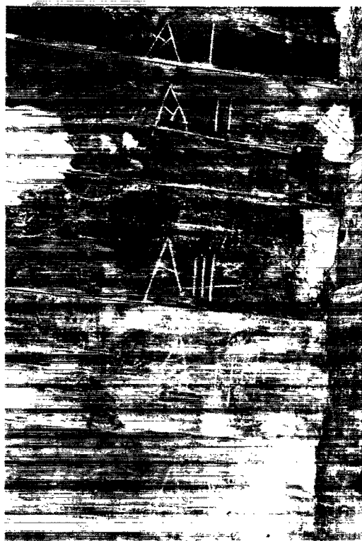
Indvendig nummerering af stokværk. En nummerering af tømmeret letter arbejdet med at samle stoksværkshusene efter flytning.
