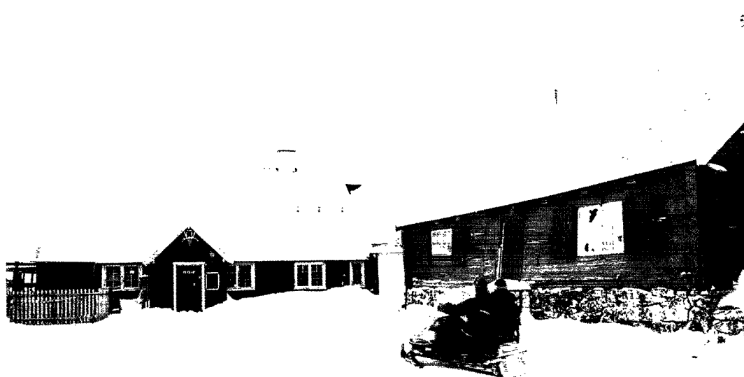
Til højre den gamle materialebutik, B-4 fra 1734, til venstre B-3 fra 1763, der siden 1990 har fungeret som museum.
